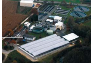
Kläranlage Stockach (50.000 EW)
